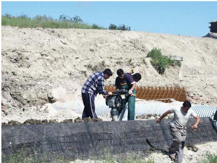
Fasi di compattazione del terreno per strati di 25-35 cm
