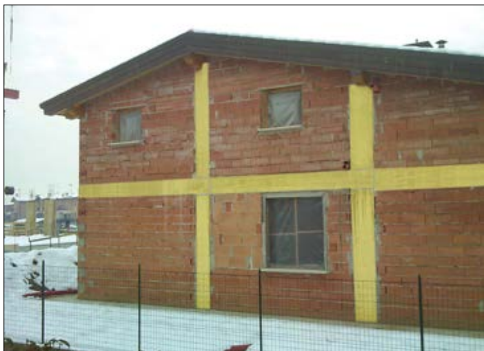
Isolamento termico dei pilastri e solai con EFYOS XPS TB
