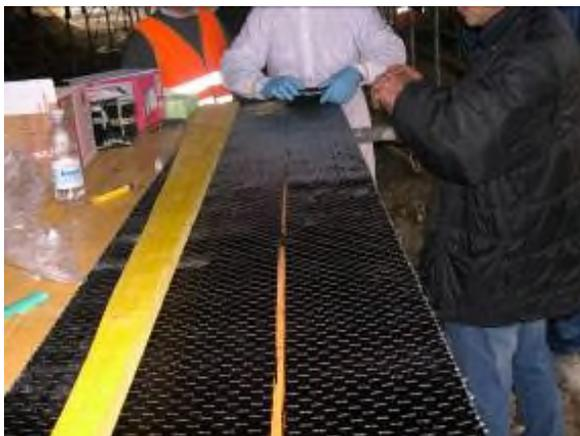
Dopo avere applicato il primo strato di adesivo, si stenderà il tessuto unidirezionale avendo cura di premerlo per due o tre volte nella direzione longitudinale della fibra usando un rullino a denti smussati e paralleli alla direzione delle fibre per eliminare l'aria dallo strato di resina. Per congiungere più strisce nella direzione longitudinale della fibra è necessario sovrapporle per una lunghezza di 20 cm.
